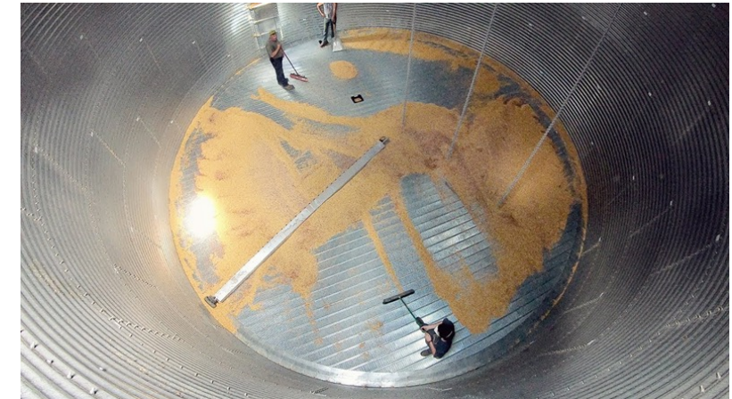
Cono invertido – Silo de acero
