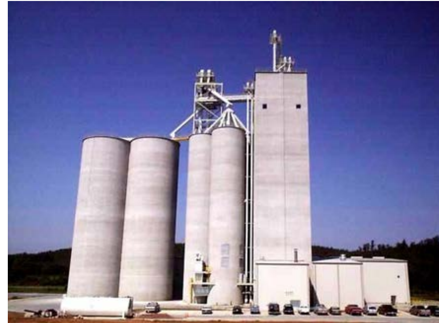
Torres de Concreto o Metal
